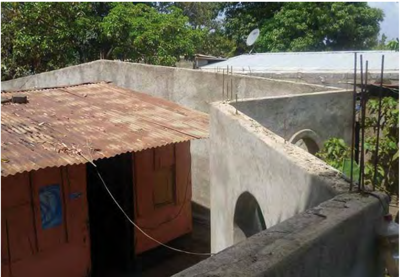
Das neue Haus wird um die alte Hütte herum gebaut, bevor später der Innenausbau erfolgt.
